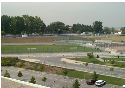
Infra-estruturas desportivas do Campus Politécnico de Viseu
